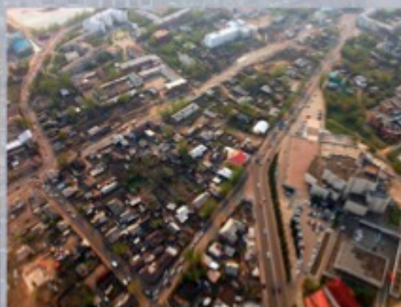
130-й квартал г.Иркутск (до реконструкции)
